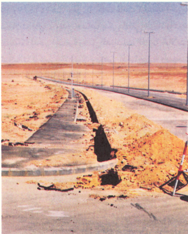
أحد أجزاء تمديدات شبكة المياه لحي النخيل والسبعين عام ١٤١١هـ
