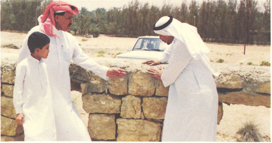
أمير الروضة يشرح أعمال الترميم التي جرت على ظهر سد السبعين
