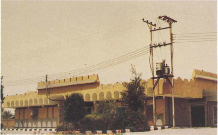
سوق الخضار بالمدخل القديم للمدينة، وقد أعدت به أماكن للتبريد والحفظ، كي يظل الخضار طازجًا.
