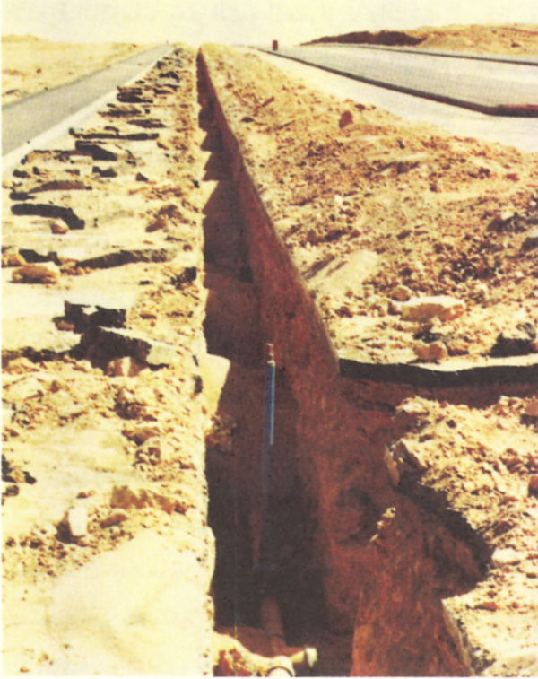
مشروع تمديدات شبكة المياه بحي النخيل وحي السبعين عام ١٤١١هـ
